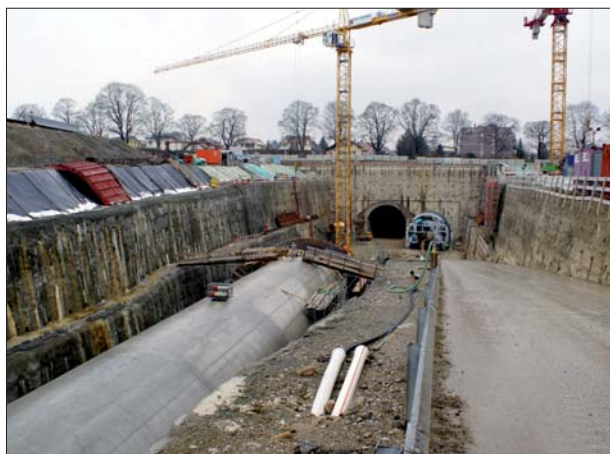
Longue de 465 m, la tranchée couverte des Granges s'abouche à une profondeur de 15 m environ au portail sud du tunnel sous la Trême.
