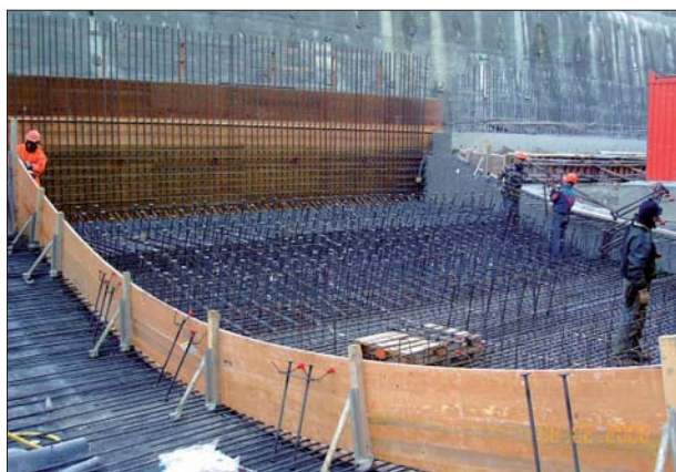
TC des Granges: armatures verticales de 90 cm de hauteur placées dans le radier de la tranchée couverte, dans les murs pieds droits puis dans les voûtes de façon à renforcer la résistance au cisaillement.
