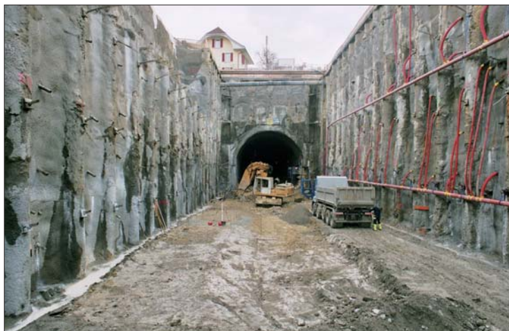
TC des Usisniers (265 m): enceinte de fouille et entrée nord du tunnel sous la Trême, le 2 avril 2008 (photo: Eric Sauterel).
