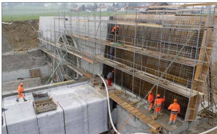
Les murs en pied de talus sont intégrés aux murs latéraux du portail des Granges. Du côté gauche de la route, le mur du portail fait office de mur de façade pour le local technique sud.
