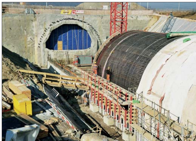
TC Moncalia (349 m): ferrailage étape de voûte, le 13 février 2008 (photo: Eric Sauterel).
