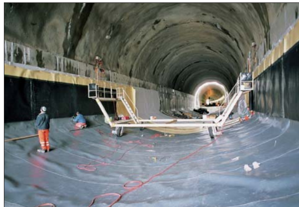
Tunnel sous voies TPF: travaux d'étanchéité, le 2 avril 2008 (photo: Eric Sauterel).
