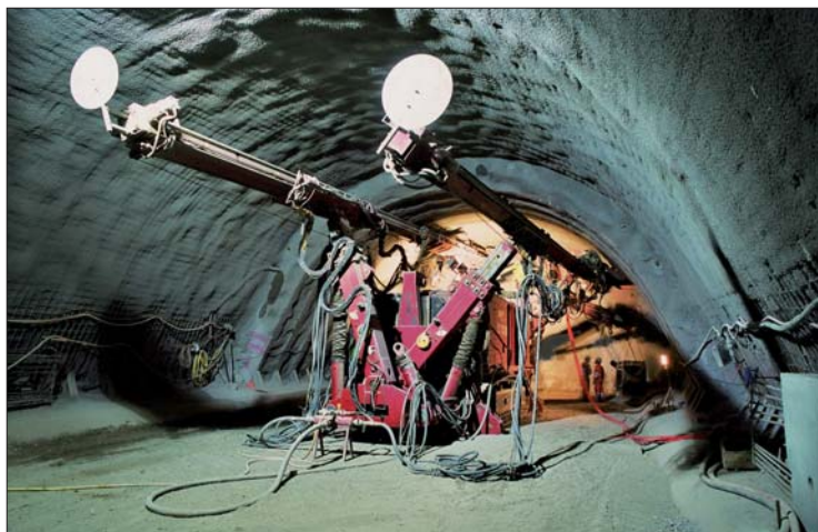
Tunnel sous la Trême: injection des colonnes Jetgrouting, 23 mai 2007.
